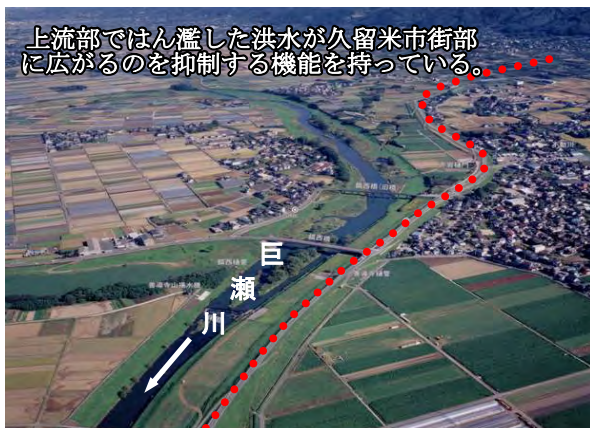
写真 2.2-1 巨瀬川左岸の控堤（久留米市）
