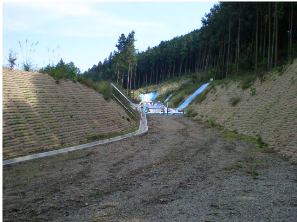
写真 3.3-3 付替国道 進入路
