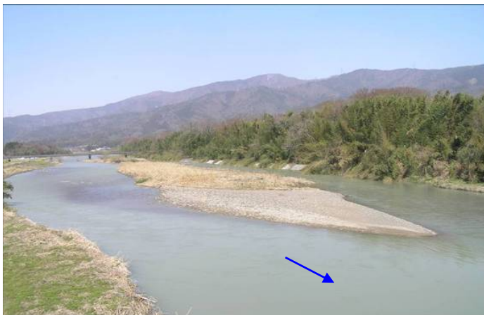
高時川12.0k付近：堤外側
