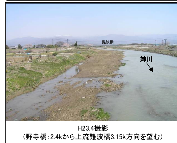
河道内の樹木の伐採状況
