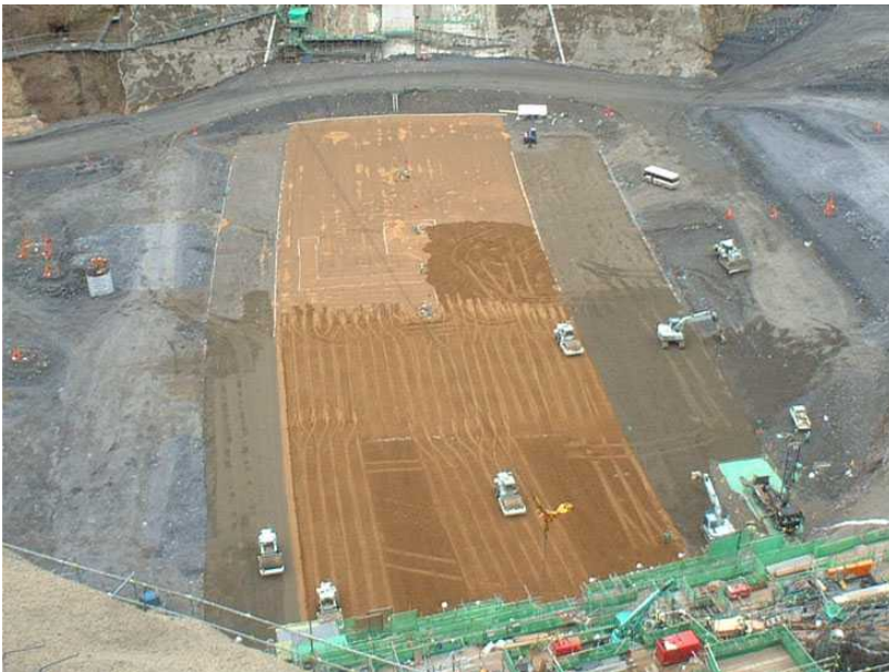
堤体工（他ダム事例）
