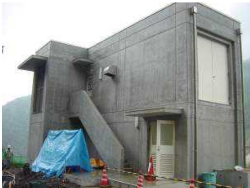
エレベータ設備（他ダム事例）
