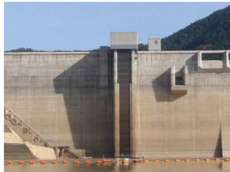
選択取水設備（他ダム事例）
