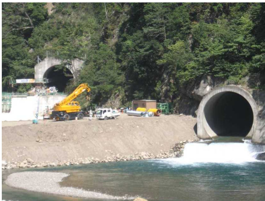
仮排水トンネル（他ダム事例）
