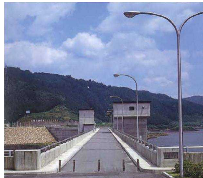
照明設備（他ダム事例）
