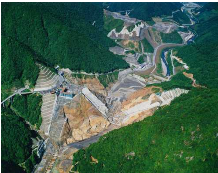
基礎掘削（他ダム事例）
