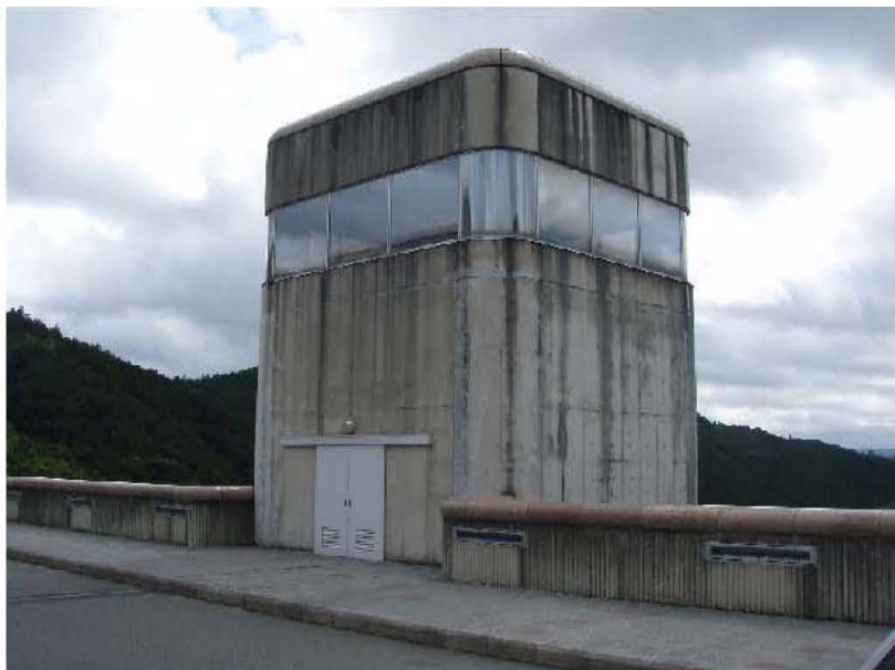
エレベータ設備（他ダム事例）
