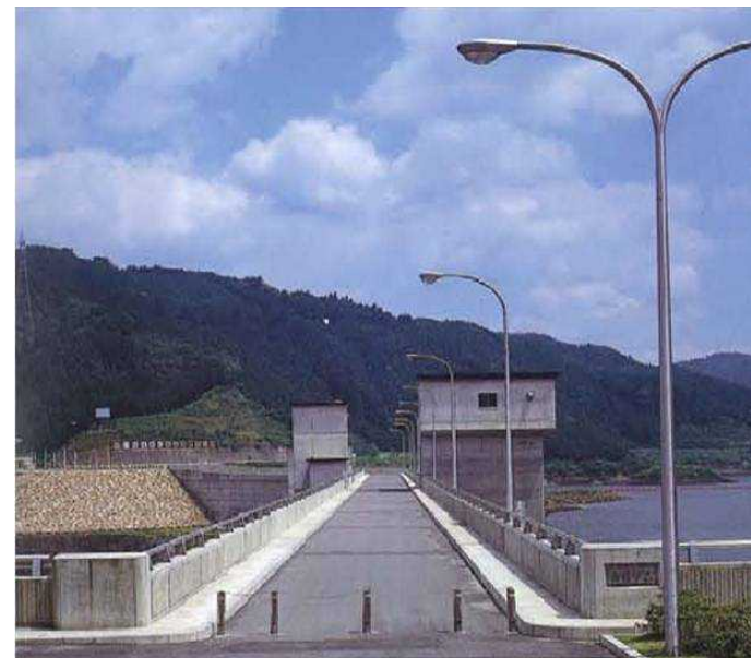
照明設備（他ダム事例）
