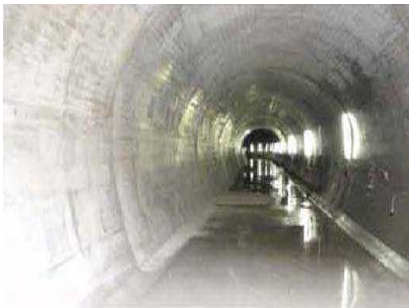
仮排水トンネル（他ダム事例）
