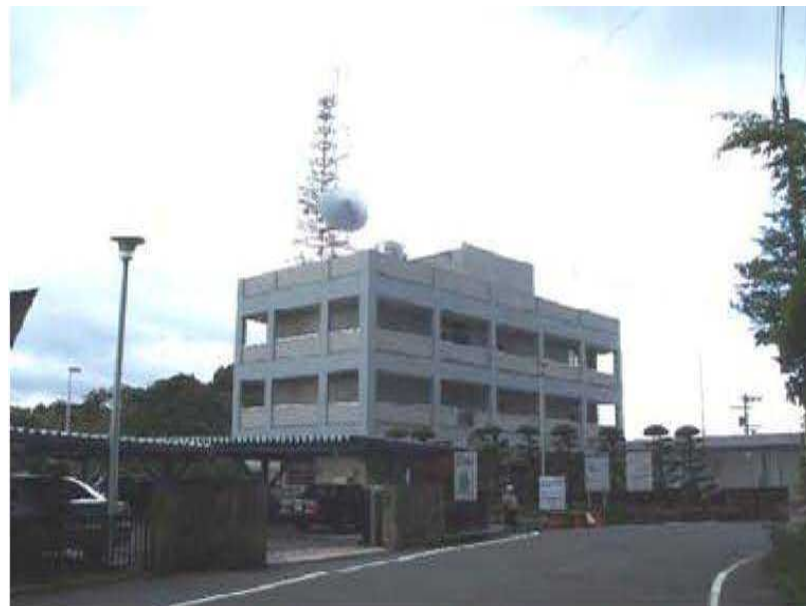
管理所（他ダム事例）
