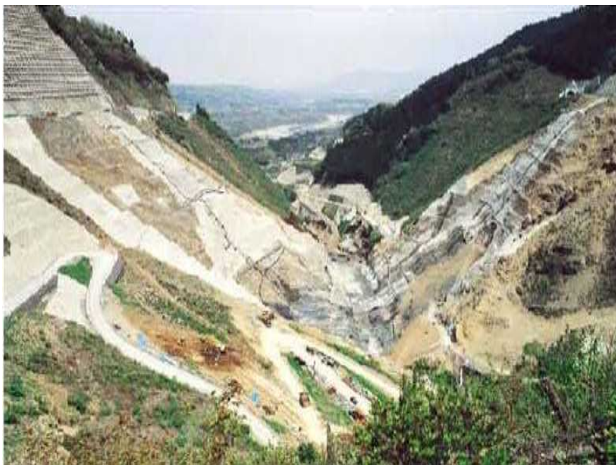
基礎掘削（他ダム事例）
