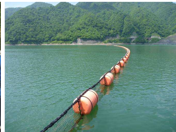
流木止設備（他ダム事例）
