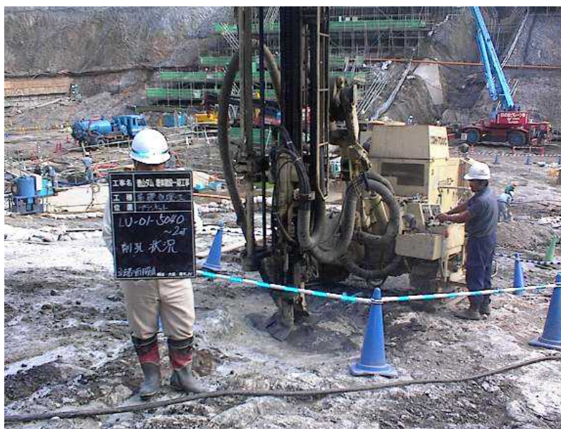
グラウチング状況（他ダム事例）
