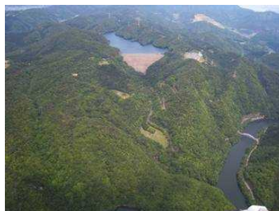
喜撰山ダム（揚水式発電の上池）
