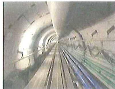
d) 石岡トンネル（建設中）
