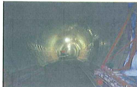
d) 仮排水トンネル
