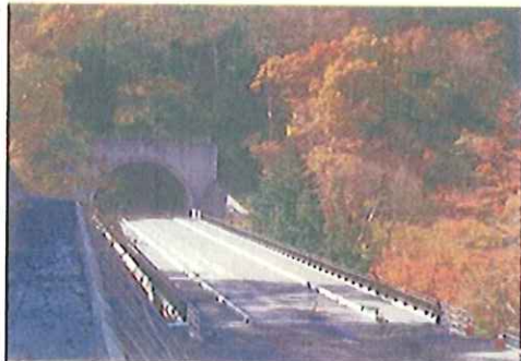
a) 付替県道工事(大沢橋・川原湯温泉トンネル)
