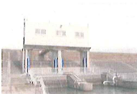
a) 利根樋管
