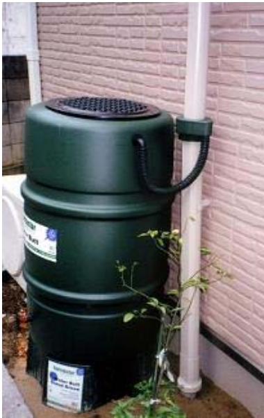
雨水貯留タンク 出典:足立区HP
