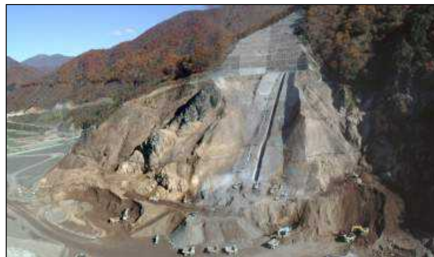
掘削工 (他ダム事例)
