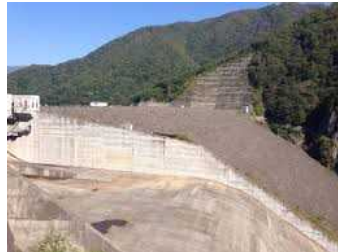
ダムサイト法面処理（他ダム事例）
