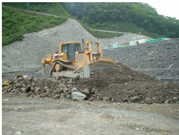
ブルドーザによる敷均（他ダム事例）
