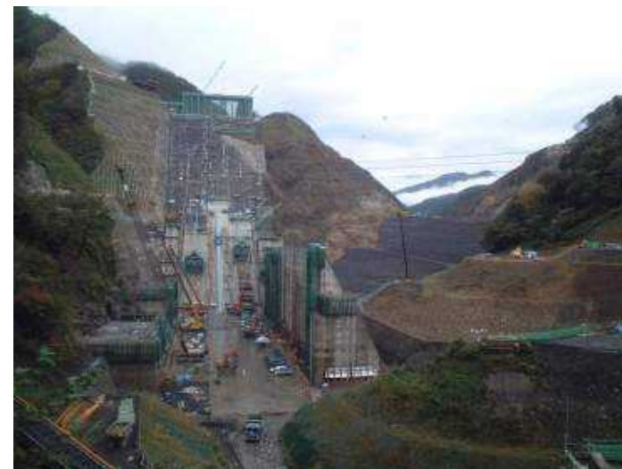
洪水吐き施工状況 (他ダム事例)
