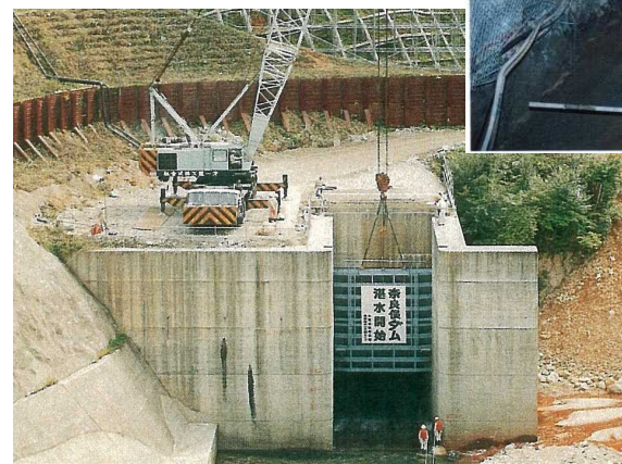
仮排水路閉塞ゲート (他ダム事例)
