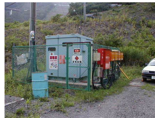
変電設備 (他ダム事例)
