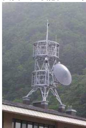
通信設備写真（他ダム事例）
