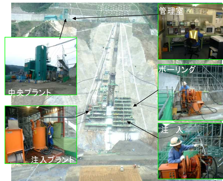
グラウチング設備（他ダム事例）
