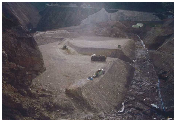
仮締切堤盛立工事（他ダム事例）
