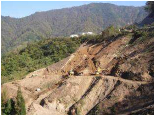
材料山伐採状況（他ダム事例）
