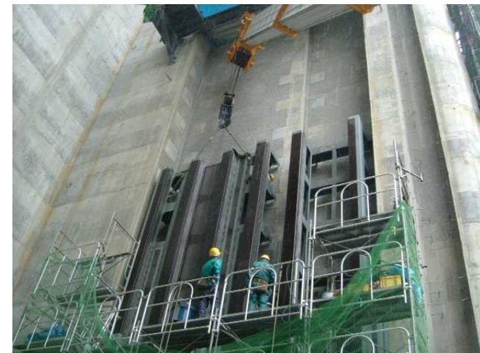
取水ゲートの設置（他ダム事例）
