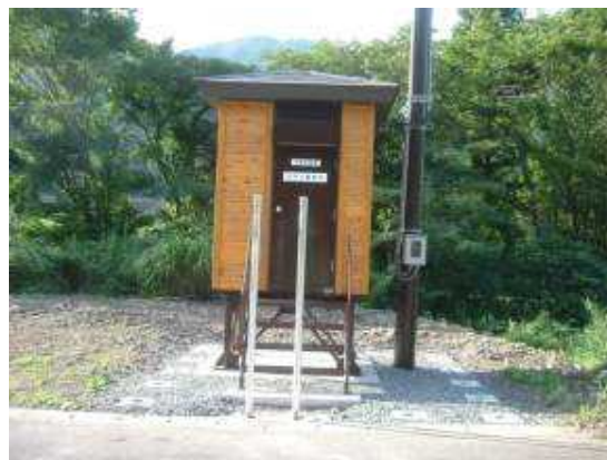
警報局舎写真（他ダム事例）
