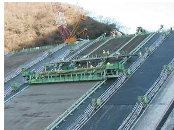
スラブ打設（他ダム事例）
