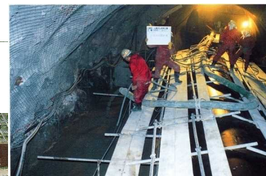
閉塞コンクリート打設 (他ダム事例)
