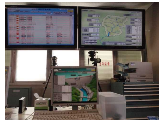
ダム操作制御設備（他ダム事例）
