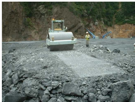
振動ローラーによる転圧（他ダム事例）
