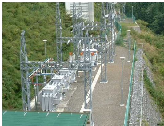
特高受電設備 (他ダム事例)
