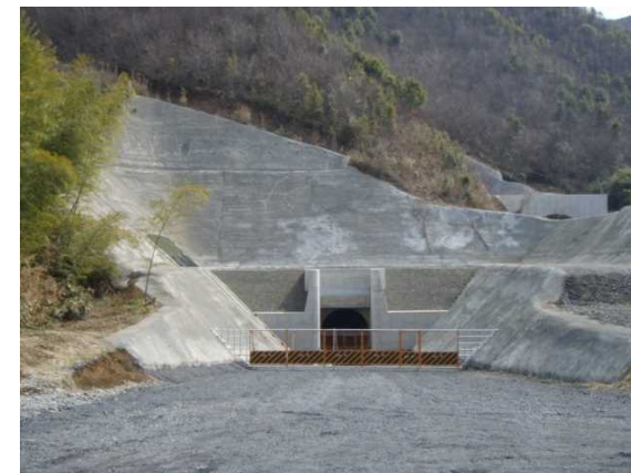
仮排水路トンネル（上流側）
