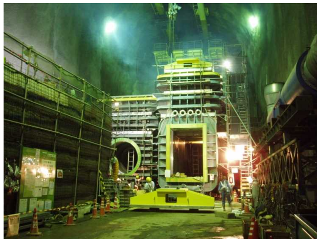
放流バルブの据付（他ダム事例）
