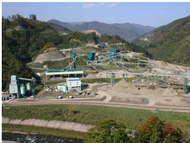
コンクリート製造設備（他ダム事例）
