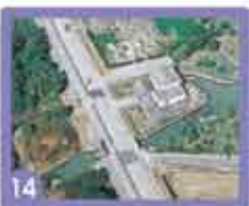
早崎下八木排水機場
