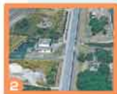
入道沼排水機場
