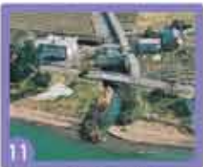
稲枝排水機場
