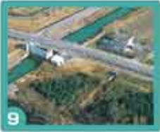
駄場排水機場
