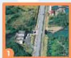
針江排水機場
