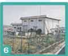
赤野井排水機場
