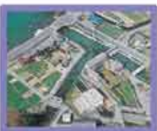
米原排水機場
