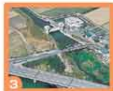
金丸川排水機場
