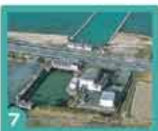
安治排水機場
