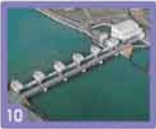
大同川排水機場
