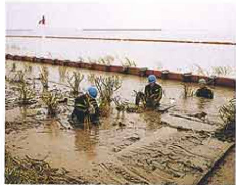
③造成したヨシ植栽地に穴を掘り、切り取ったヨシ苗を移植します。
