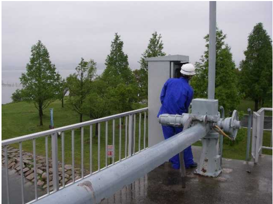
樋門の閉操作状況
