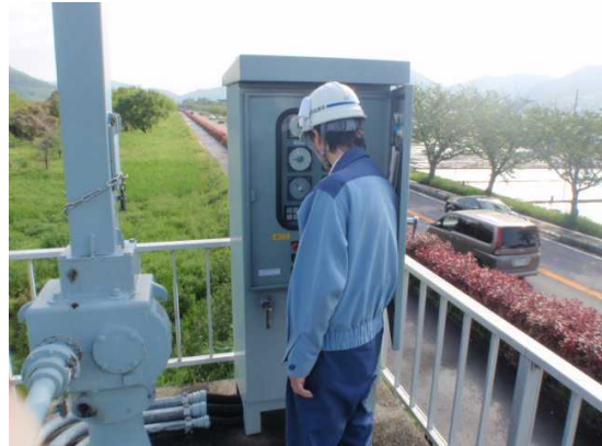
樋門の閉操作状況
