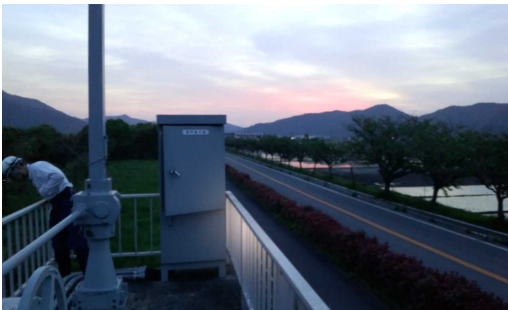
樋門の開操作前の確認
