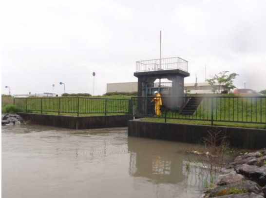
樋門下流（琵琶湖側）の確認
