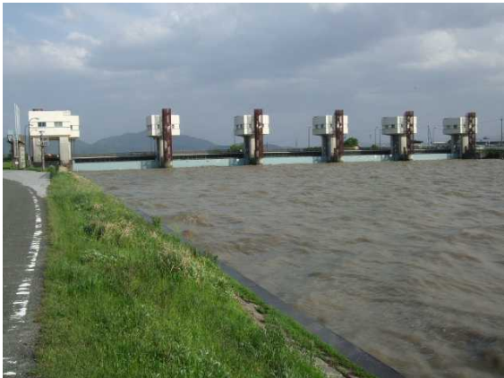
大同川水門操作状況（全閉）
