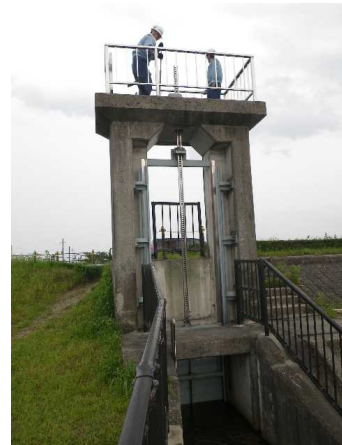
樋門の開操作状況
