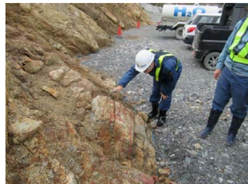
安威川ダム建設現場での岩盤調査
