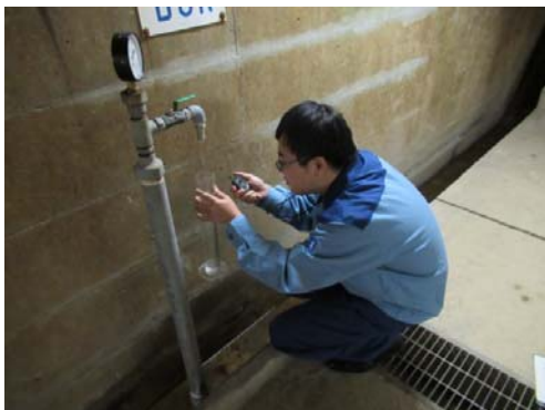
堤体観測（漏水量計測）の体験
