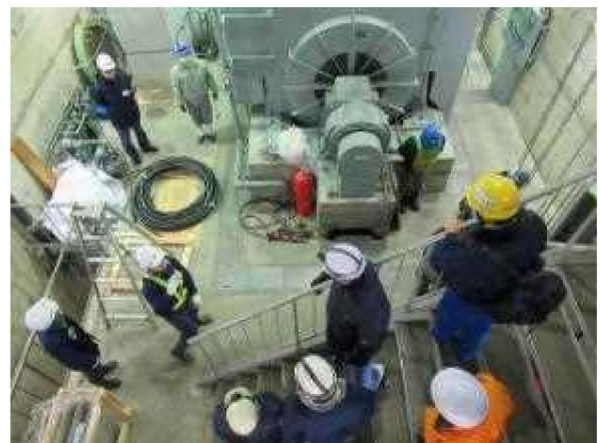
工事現場のパトロール
