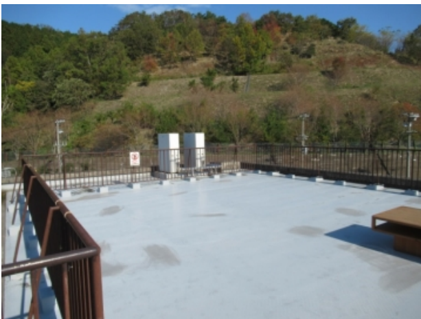
屋上スペースの様子
