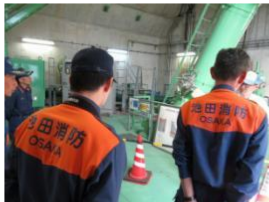
ダム視察状況（常用洪水吐ゲート機側操作室）
