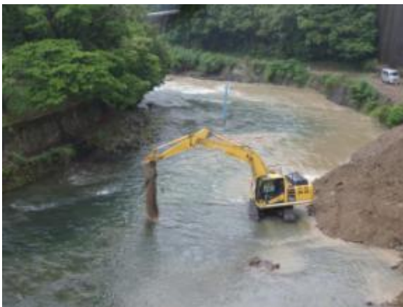
土砂還元実施状況
