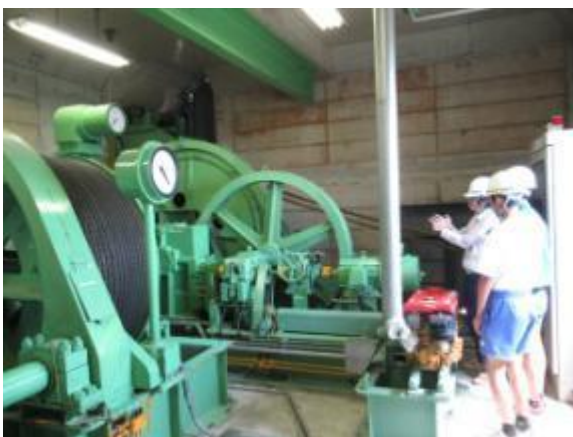
機械設備の点検
