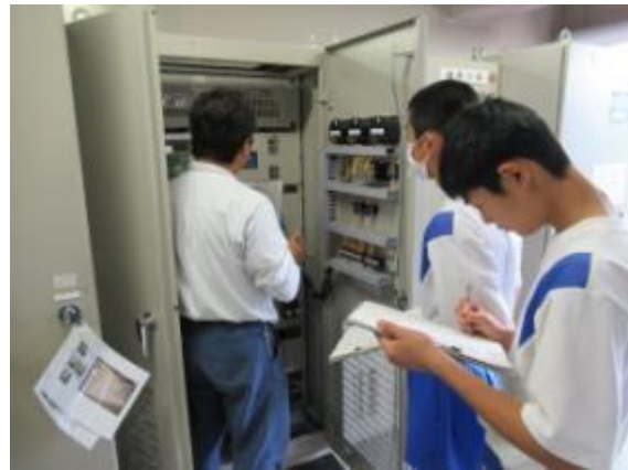
電気通信設備の点検
