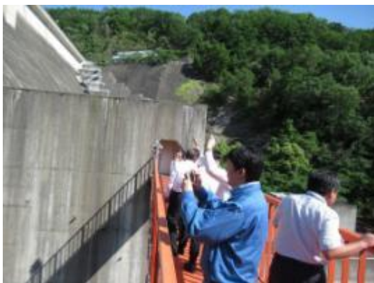
ダム視察状況（非常用洪水吐ゲートを見上げる）
