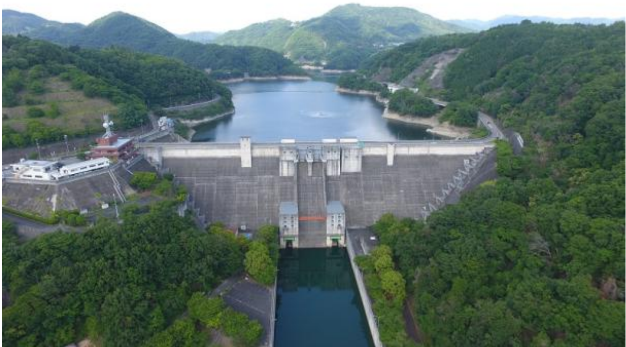
貯水池の状況(R1. 6. 5 撮影)貯水位 EL. 139. 14m (平年値 EL. 137. 83m)
