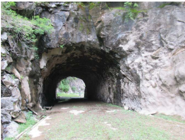
手堀りの跡が残る隧道
