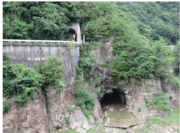
上：新龍化トンネル、下：龍化隧道
