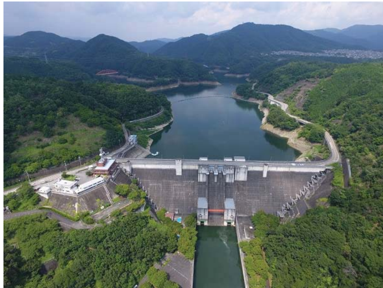
貯水池の状況(R1.7.23 撮影) 貯水位 EL.135.07m
