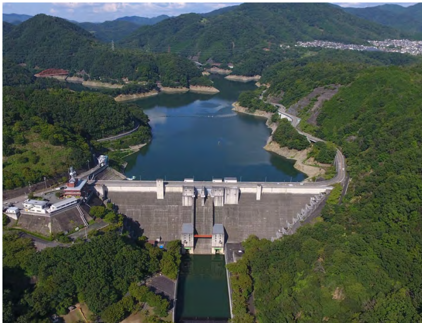
貯水池の状況(R1.8.26撮影) 貯水位 EL.135.01m
