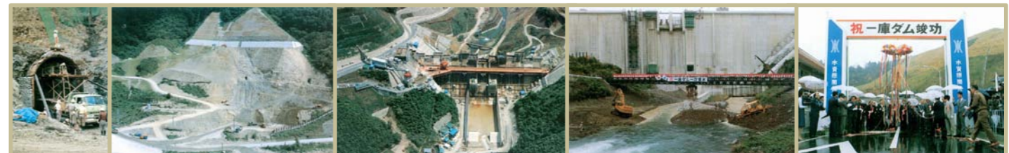
転流工 → 基礎掘削 → 本体コンクリート打設 → 試験湛水 → 完成
