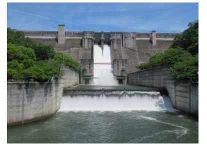
▲点検時に非常用洪水吐きゲートから試験放流
