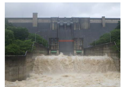
▲出水時に常用洪水吐きゲートからの放流
