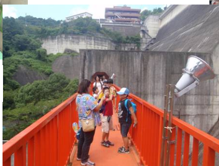
管理橋（通称・赤橋）
