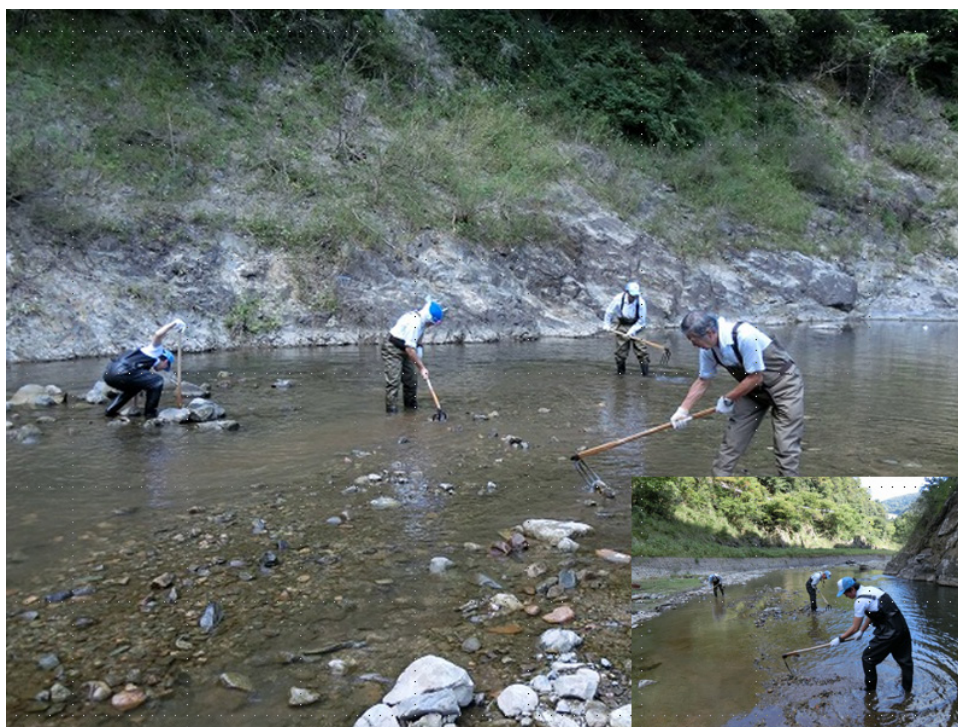
田尻川（国崎大橋上流）
