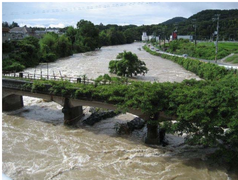
【8月2日：多田大橋下流の猪名川（樹木が茂っているのは旧多田大橋）】
