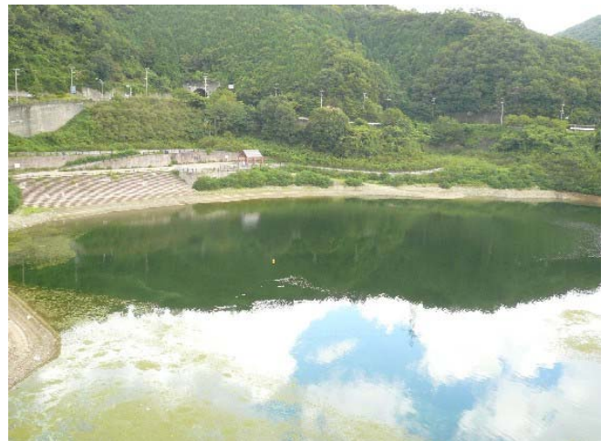
写真-⑥ 出合地区の状況
