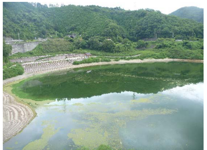
写真-④ 出合地区の状況
