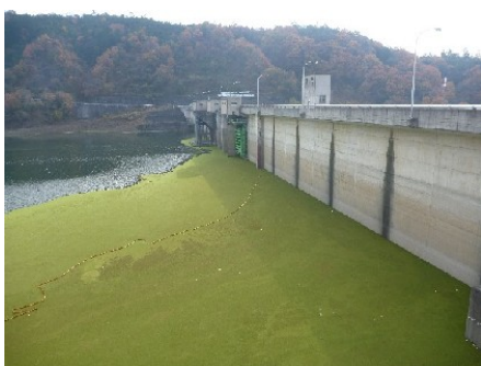
ダム堤体付近 H23. 12. 12 撮影
