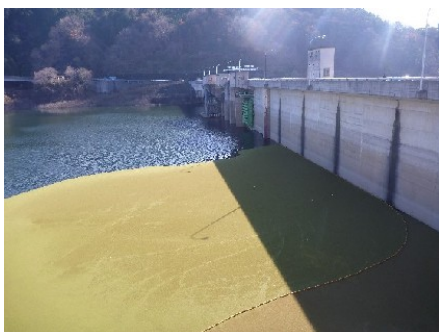
ダム堤体付近 H24. 1. 6 撮影
