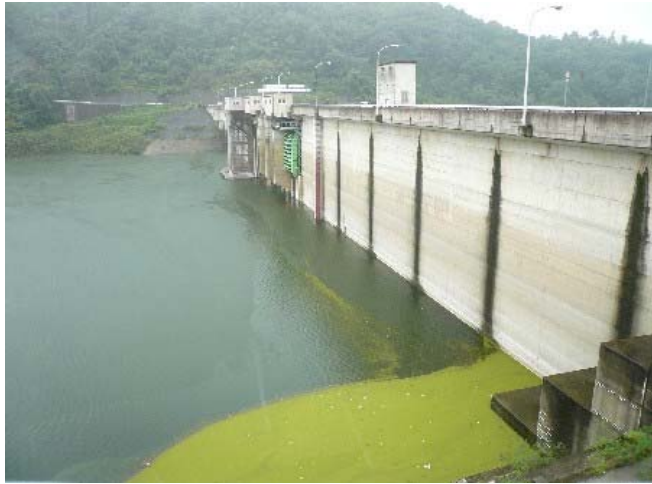
写真-① ダム堤体付近の状況 (淡緑色部分はウキクサ)
