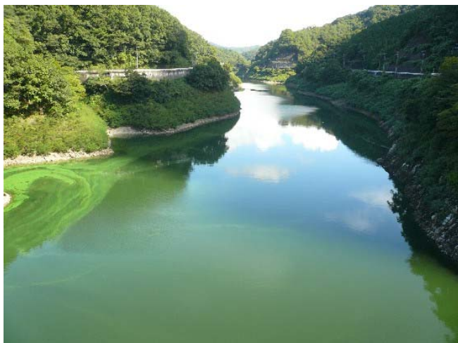
写真-③ りんどう橋より上流の状況
