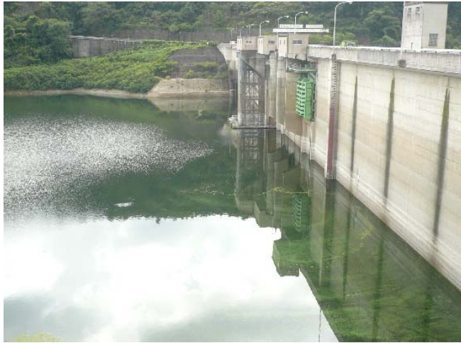
写真-① ダム堤体付近の状況
