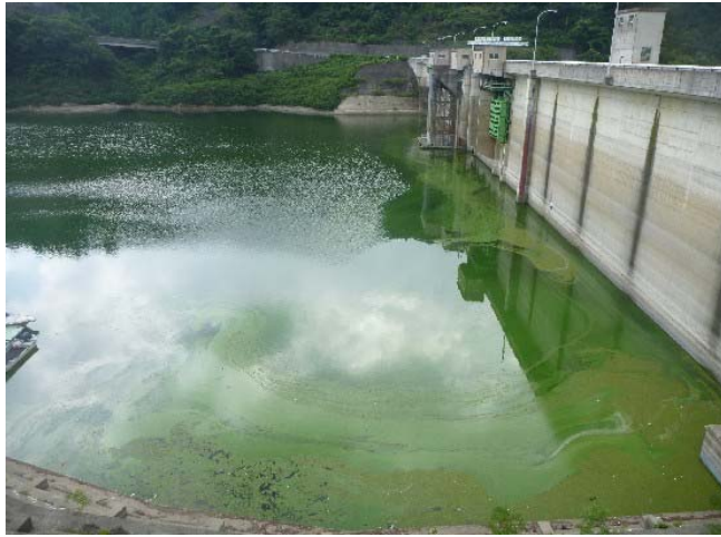
写真-① ダム堤体付近の状況
