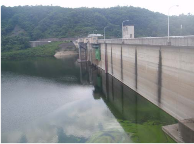
写真-① ダム堤体付近の状況
