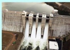
非常用洪水吐きから放流 (試験放流中の写真)
