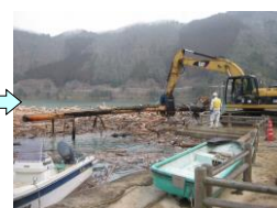
流木引き揚げ作業
