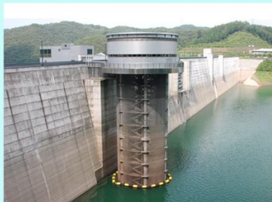
選択取水設備全景
