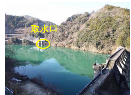
①新庄発電所取水口
