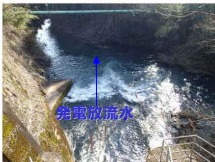
⑥新庄発電所放流口
