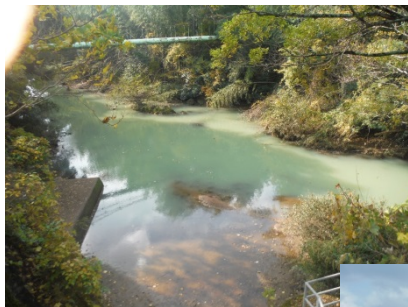
⑥新庄発電所 放流口(停止中)
