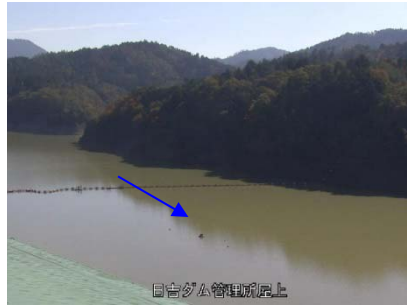
③日吉ダム貯水池
