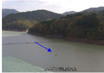
③日吉ダム貯水池
