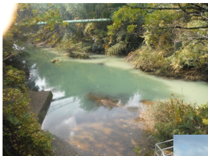
⑥新庄発電所 放流口(停止中)
