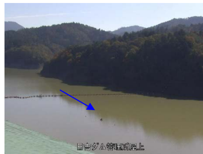
③日吉ダム貯水池
