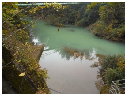
⑥新庄発電所 放流口(停止中)
