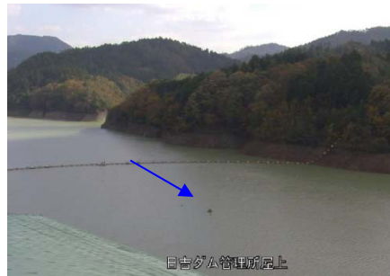
③日吉ダム貯水池
