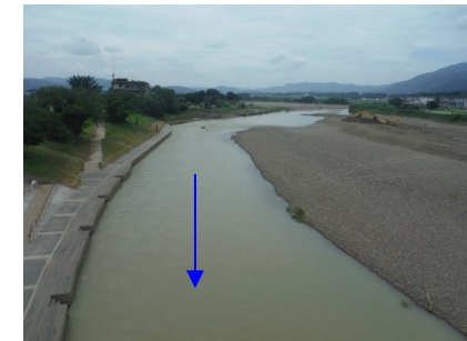
⑨保津橋上流
