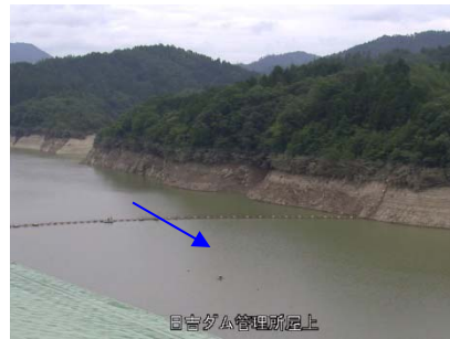
③日吉ダム貯水池
