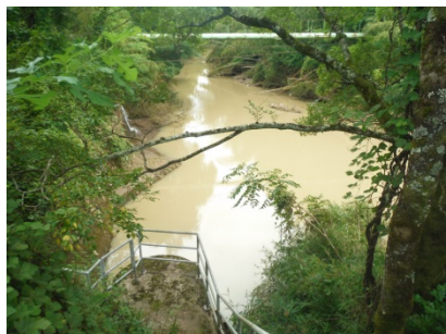
⑥新庄発電所 放流口(停止中)
