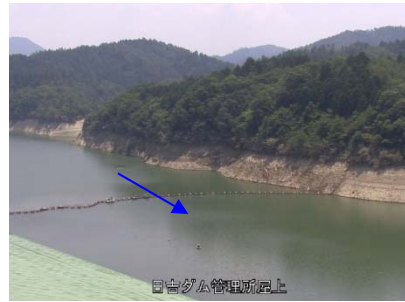
③日吉ダム貯水池
