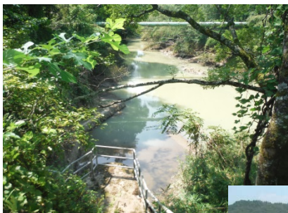
⑥新庄発電所 放流口(停止中)
