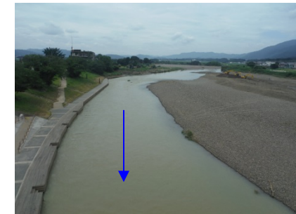
⑨保津橋上流
