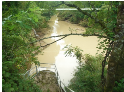
⑥新庄発電所 放流口(停止中)
