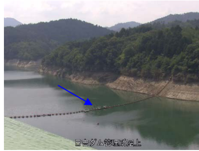
③日吉ダム貯水池
