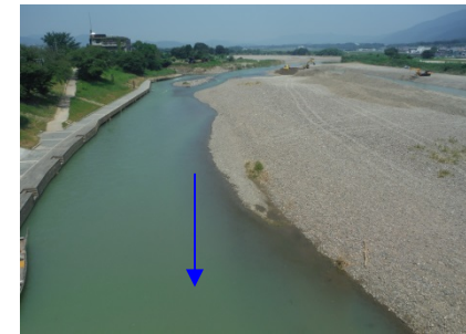
⑨保津橋上流
