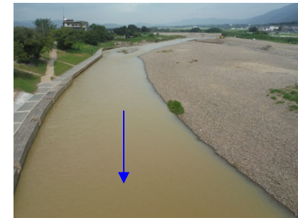
⑨保津橋上流
