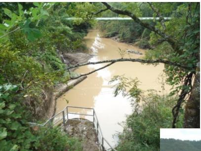
⑥新庄発電所 放流口(停止中)
