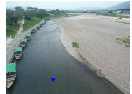
⑨保津橋上流
