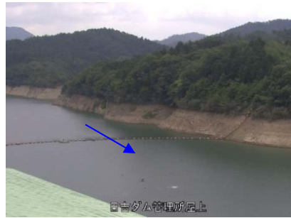
③日吉ダム貯水池
