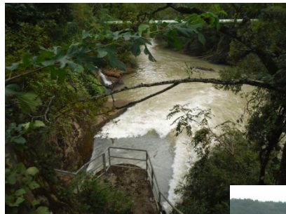
⑥新庄発電所 放流口(停止中)
