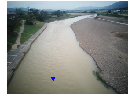
⑨保津橋上流
