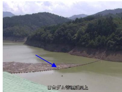
③日吉ダム貯水池
