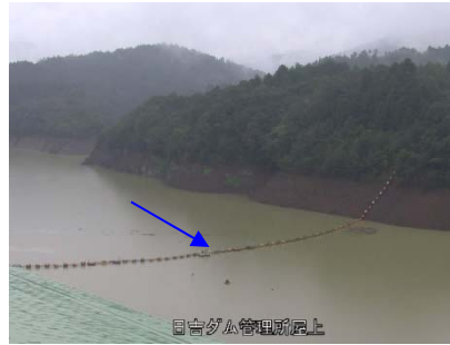
③日吉ダム貯水池
