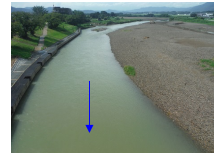
⑨保津橋上流
