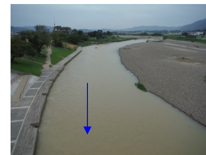
⑨保津橋上流
