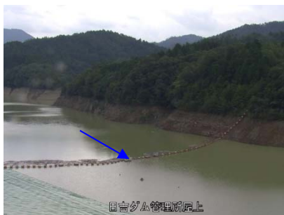
③日吉ダム貯水池
