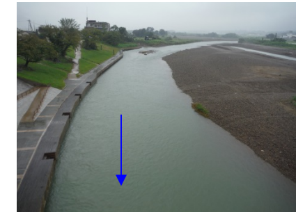
⑨保津橋上流
