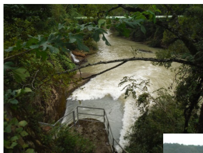
⑥新庄発電所 放流口(停止中)
