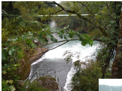
⑥新庄発電所 放流口(運転中)
