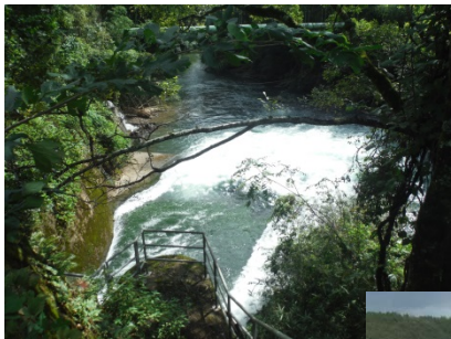
⑥新庄発電所 放流口(運転中)
