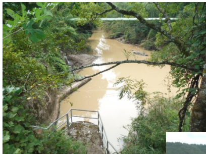
⑥新庄発電所 放流口(停止中)
