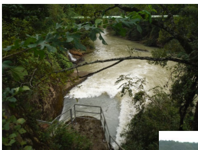
⑥新庄発電所 放流口(停止中)
