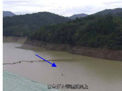
③日吉ダム貯水池
