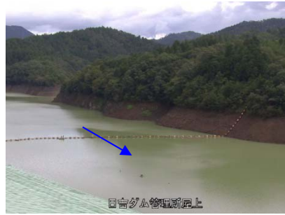
③日吉ダム貯水池
