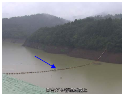
③日吉ダム貯水池
