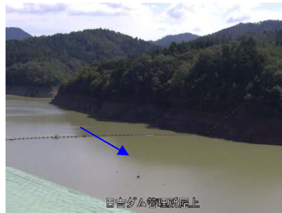
③日吉ダム貯水池
