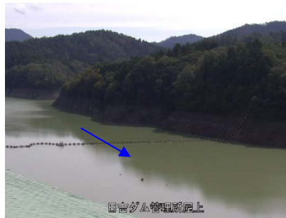
③日吉ダム貯水池
