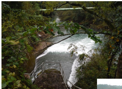
⑥新庄発電所 放流口(運転中)
