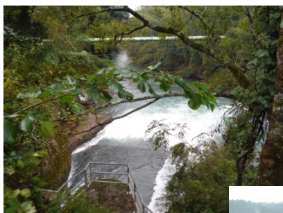
⑥新庄発電所 放流口(運転中)
