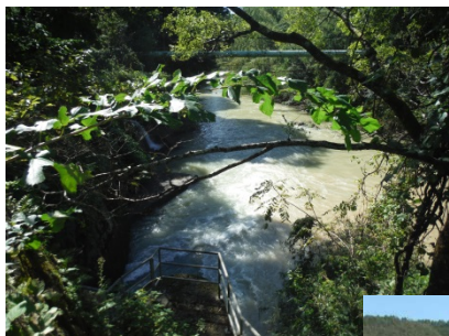
⑥新庄発電所 放流口(運転中)
