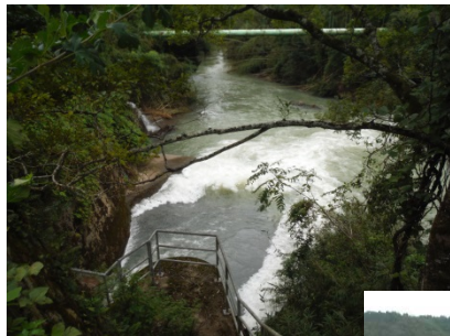
⑥新庄発電所 放流口(運転中)
