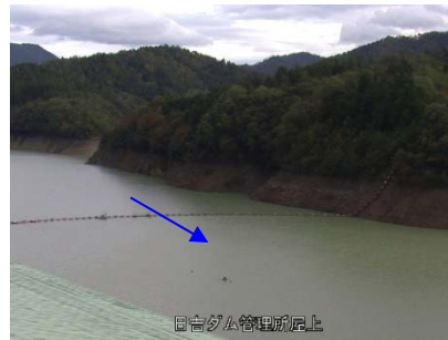
③日吉ダム貯水池
