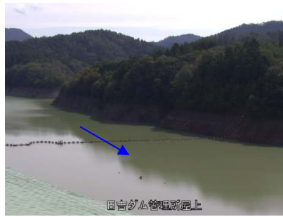
③日吉ダム貯水池
