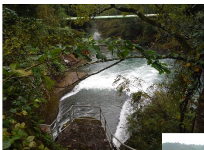
⑥新庄発電所 放流口(運転中)
