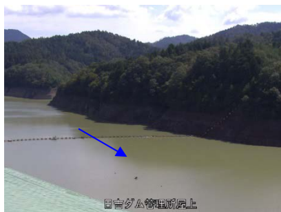
③日吉ダム貯水池
