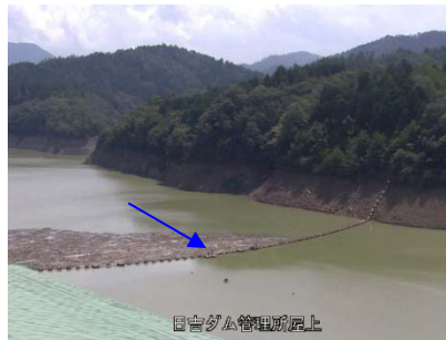
③日吉ダム貯水池
