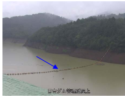
③日吉ダム貯水池
