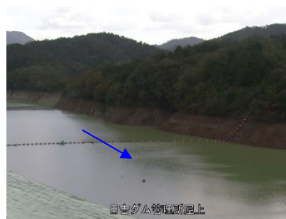
③日吉ダム貯水池
