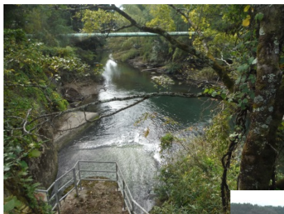
⑥新庄発電所 放流口(運転中)
