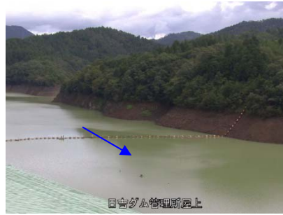
③日吉ダム貯水池
