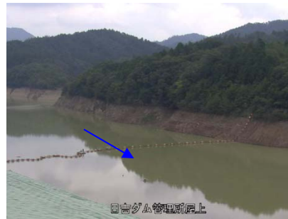
③日吉ダム貯水池
