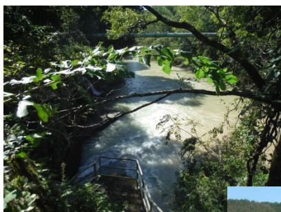
⑥新庄発電所 放流口(運転中)
