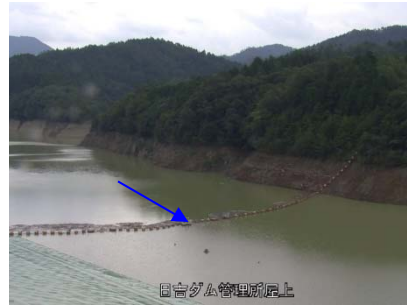
③日吉ダム貯水池
