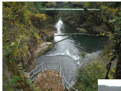
⑥新庄発電所 放流口(運転中)
