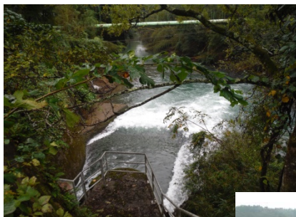
⑥新庄発電所 放流口(運転中)
