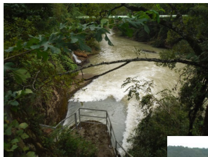
⑥新庄発電所 放流口(停止中)
