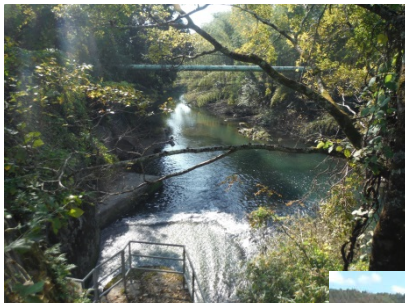
⑥新庄発電所 放流口(運転中)
