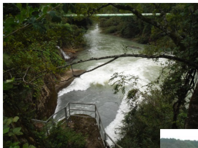
⑥新庄発電所 放流口(運転中)
