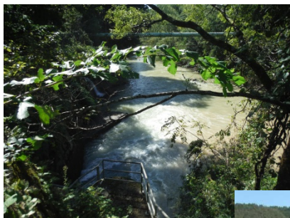
⑥新庄発電所 放流口(運転中)
