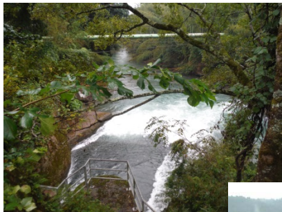
⑥新庄発電所 放流口(運転中)
