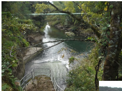
⑥新庄発電所 放流口(運転中)
