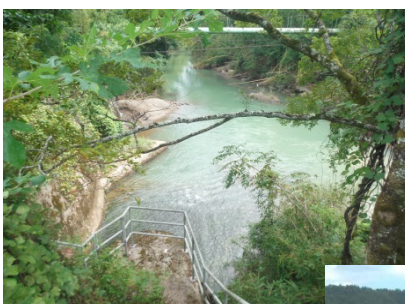
⑥新庄発電所 放流口(停止中)
