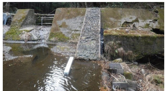
写真-2 改良したF井堰
