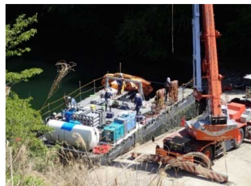
写真-7 作業台船組立状況
