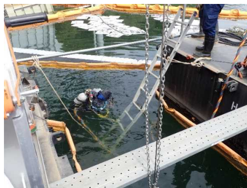
写真-9 状況確認のための潜水作業
