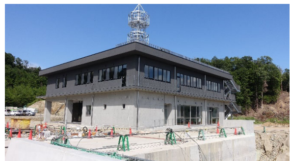
写真2 管理棟北面、西面
