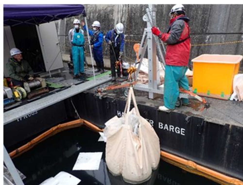
写真-10 ドラム缶引上げ状況
