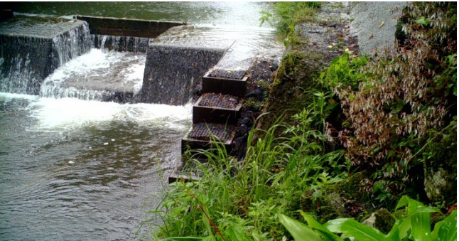
写真-1 改良後の B 井堰
