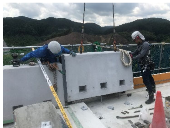
図-2 天端高欄の設置状況
