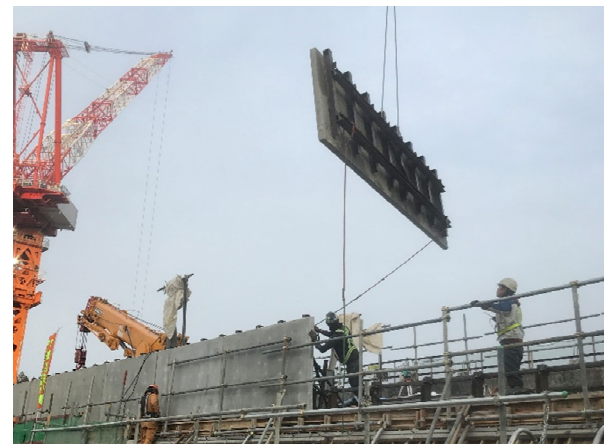
図-4 PCa型枠（下流面勾配変化点）の設置状況
