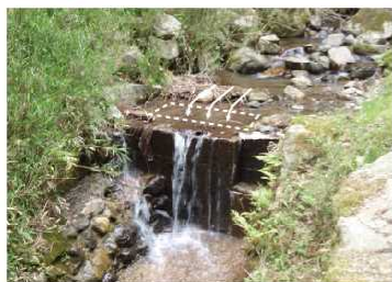
小河川からの取水状況（剣谷水源）
