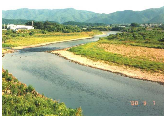
平成12年9月7日 月読橋上流
