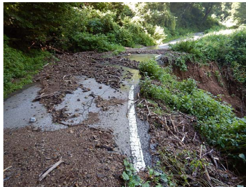
川側路肩の欠損状況(遠景)
