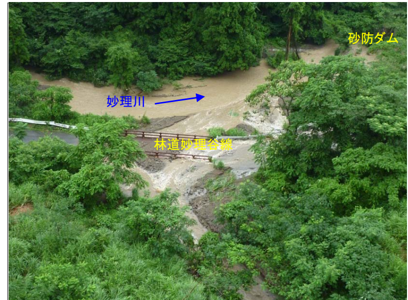
土砂流出の状(遠景)
