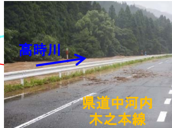
①【下丹生地区】8/8 6:58撮影 県道の冠水
