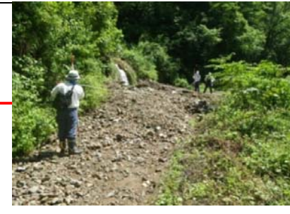
○市道奥川並線2.78km地点
