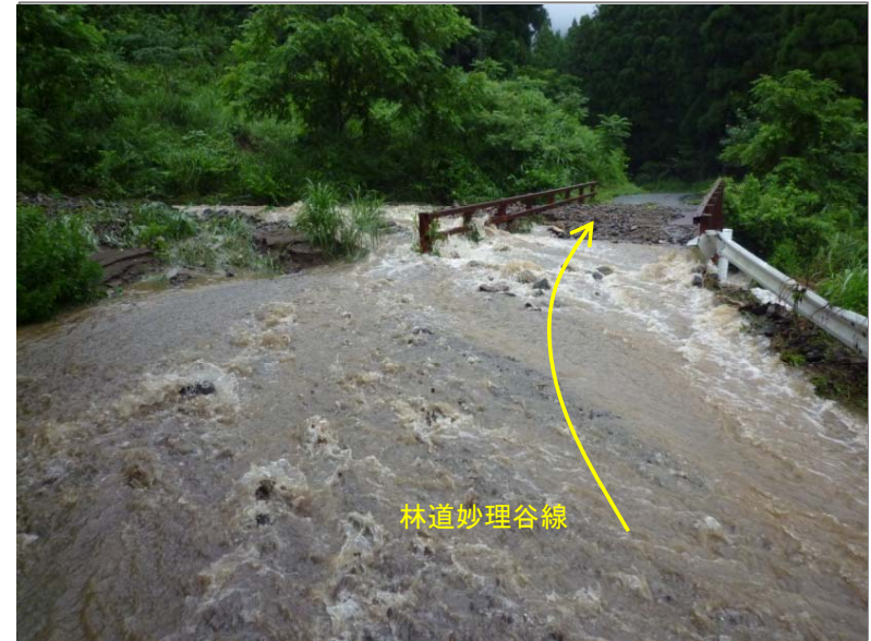
土砂流出の状況(近景)
