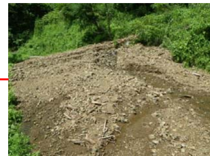
○市道奥川並線0.60km地点
