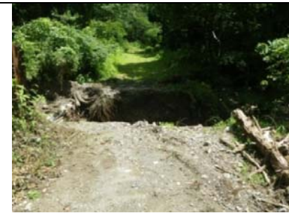
○市道奥川並線4.20km地点
