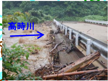
⑨【小原地区】8/8 7:19撮影 工事用道路2号線仮橋の冠水
