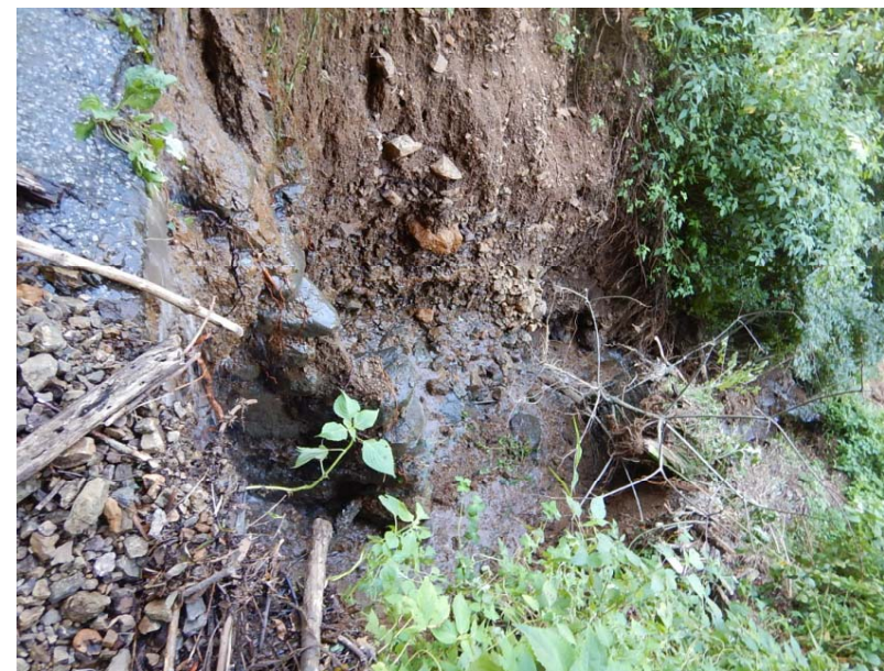
川側路肩の欠損状況(近景:道路上から下を望む)
