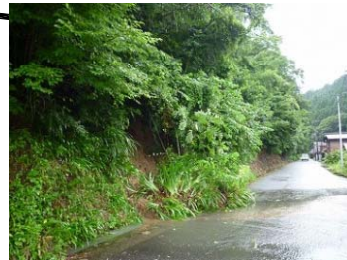
④【摺墨地区】8/8 8:40撮影 市道丹生小谷線への崩落（山側）
