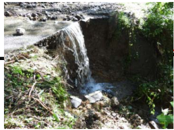
⑫【小谷地区】8/9 15:43撮影 市道丹生小谷線の路肩浸食
