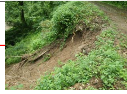
○市道奥川並線3.04km地点
