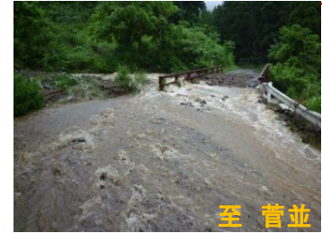
⑦【菅並地区】8/8 9:32撮影 林道妙理谷線への土砂流出
