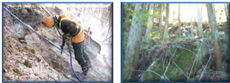
石の除去（写真左）、ワイヤー等での石の固定（写真右）の事例
