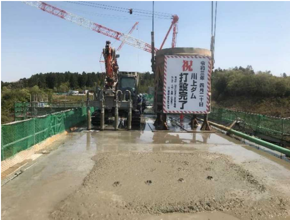
打設完了式 (令和3年4月20日)
