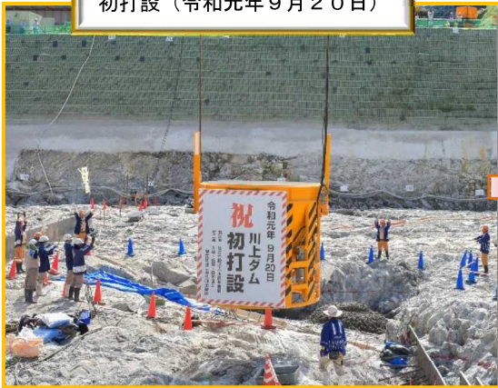
初打設 (令和元年9月20日)
