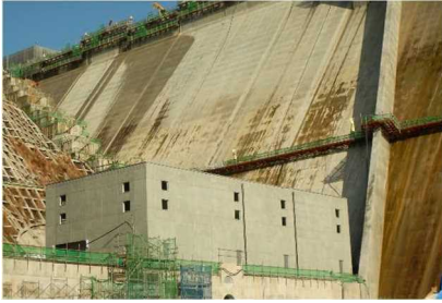
発電設備建屋の全景
