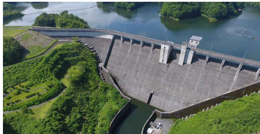
布目ダム全景
