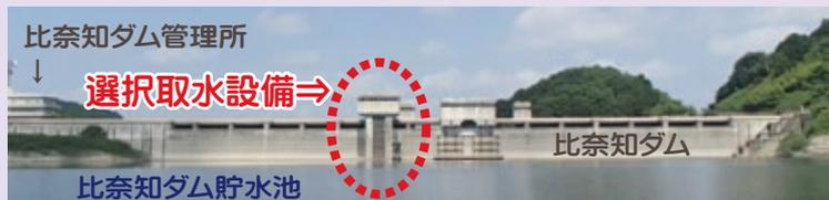
上の写真は貯水池側から見た比奈知ダムです。真ん中あたりにあるのが、放流水を取水するための選択取水設備です。中には、幅5m、高さは34mになる巨大な3段式の扉があり、右図のように上下に開閉することで、取水位置をEL.301.0mからEL.268.3mの範囲で選択できます。水温調節だけでなく、大雨で濁水が発生したとき、植物プランクトンが異常発生した時などにも取水位置を調節し、水環境の維持に務めています。
