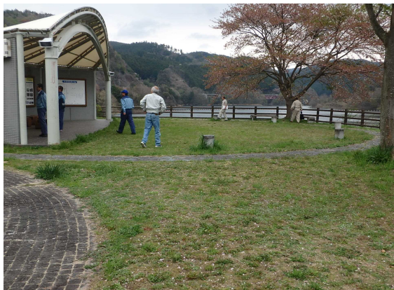
ダム展望広場(右岸)点検状況
