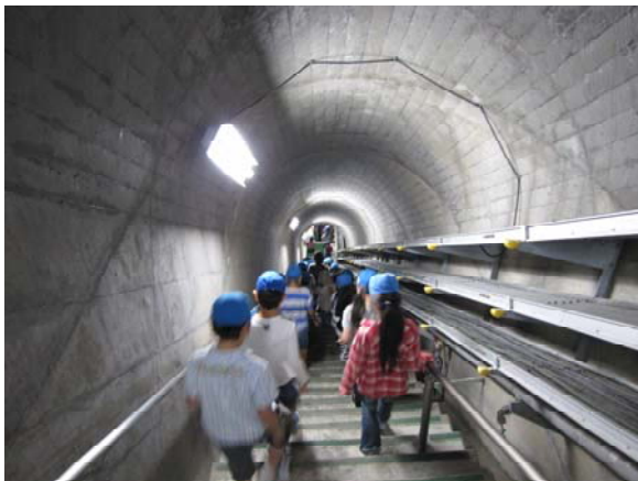
ダムの中の階段を下りて見学
