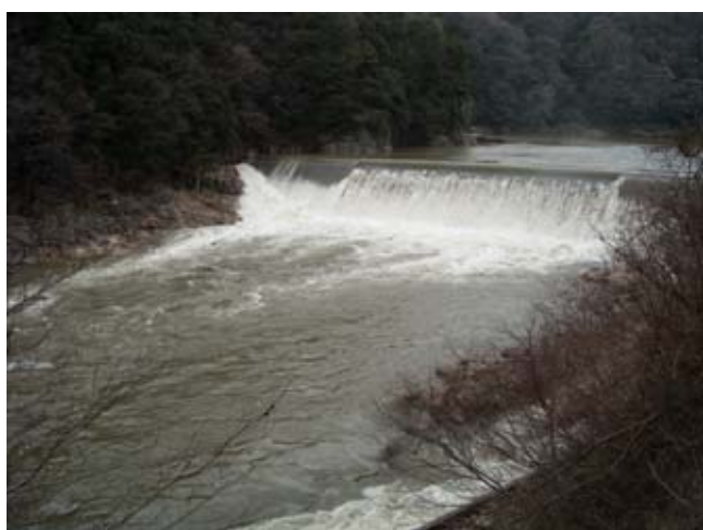
③ 大河原堰堤 (泡あり)
