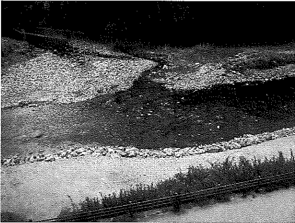
ダム下流(フラッシュ放流前) ※宇陀川と室生川合流点付近
