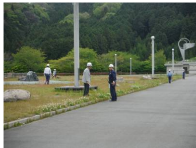
ダム堤頂部点検状況
